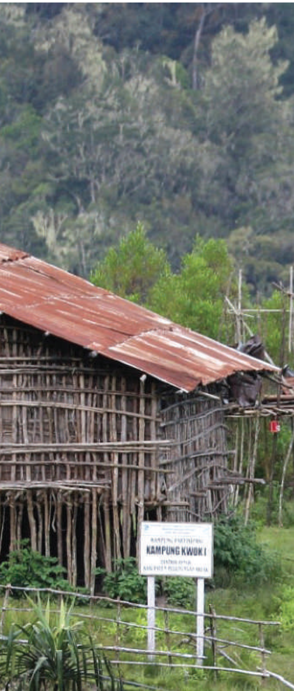
Rumah Kaki Seribu dengan modifikasi atap seng di Kampung Kwok, Distrik Hingk. Tampak papan nama Kampung Kwok "kampung partisipasi".
